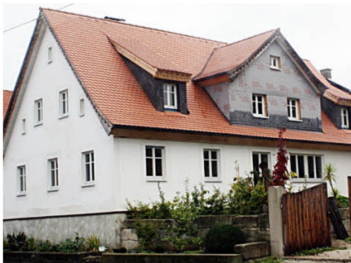
An der großen Gaube fehlen noch die Schiefer-Schindeln. Fotos: J. Hofbauer
