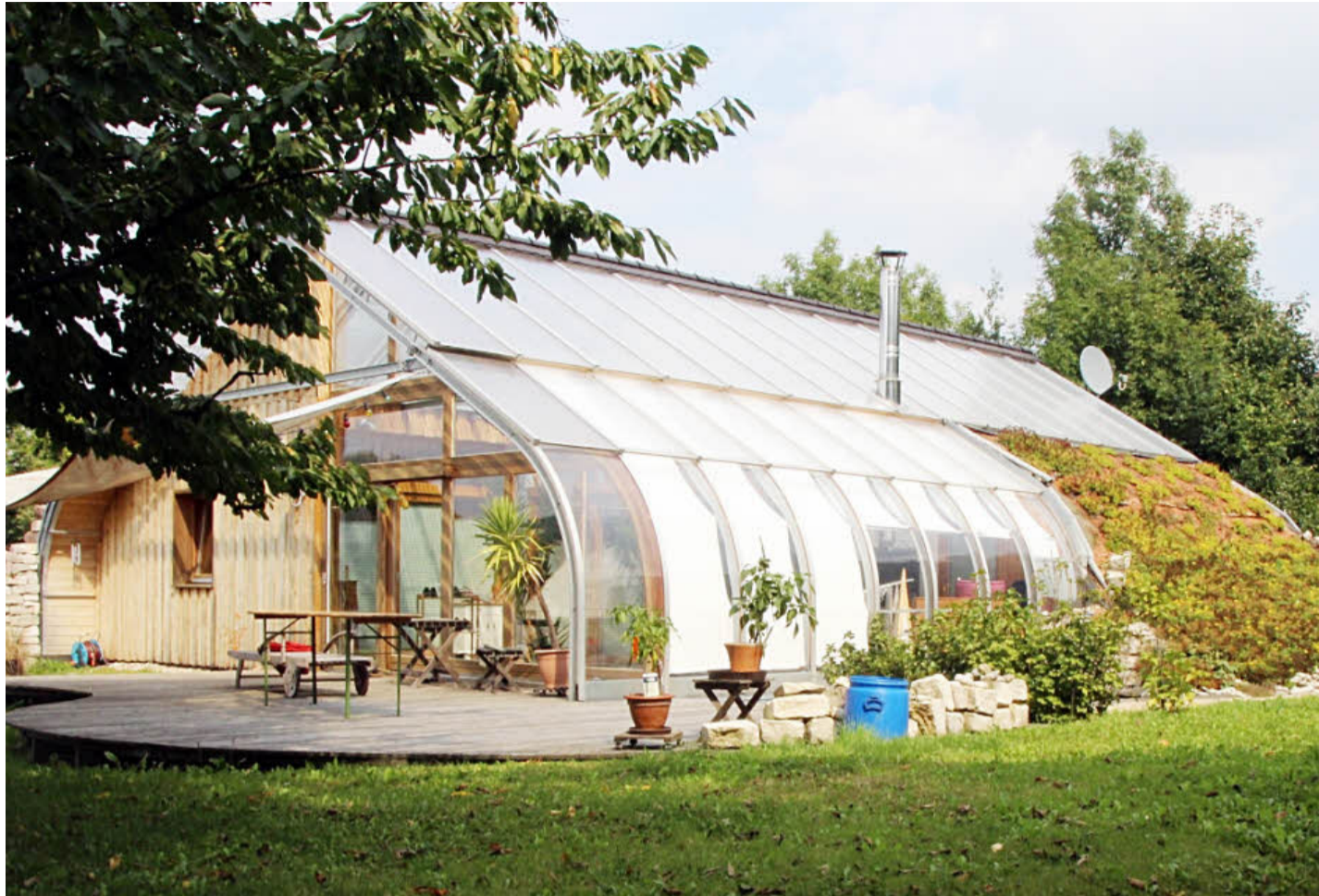
Das Regenwasser von den Glasflächen wird in einer Zisterne gespeichert und für die WC-Spülung und die Waschmaschine verwendet.
